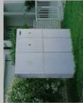
B Sčružený plastový pilíř pro Hlavní uzávěr plynu, elektroměrové a přípojkové skříně elektro
